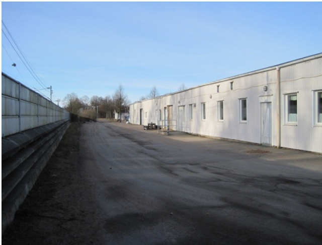
Under byggnad Häggen på gymnasieområdet finns föroreningar efter en kemtvätt. Föroreningen sträcker sig delvis under järnvägen ner mot Säveån.
