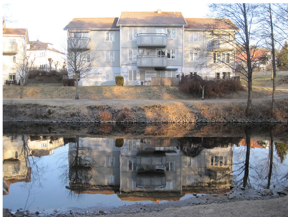
Erosionsskydd utfört med sten i olika fraktioner utefter Sävån i Lerums centrum
