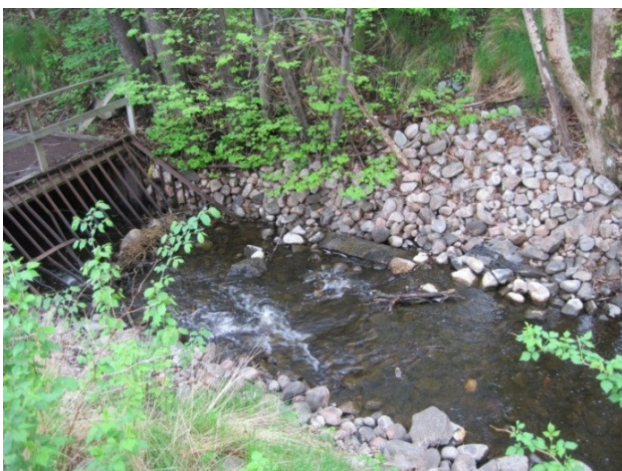
Alebäcken - Intaget till den stora kulverten under lokalvägen, E20 och järnvägen mellan Alebäcken och Aspen
