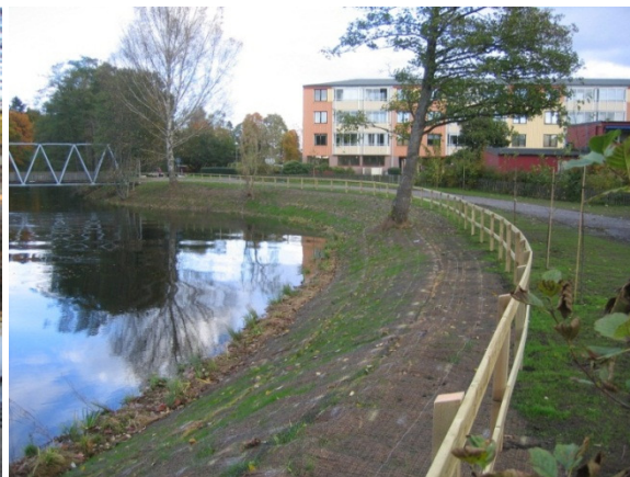
Erosionsskydd utfört med stengabioner och kokosmattor vid Nyebroparken. Bilden tagen innan växtligheten återetablerats.
